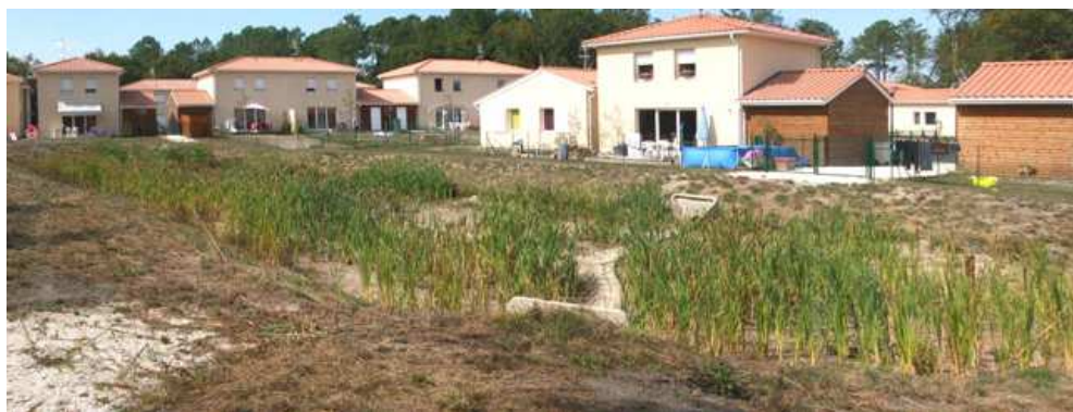
Exemple de bassin de rétention à Renaurey
