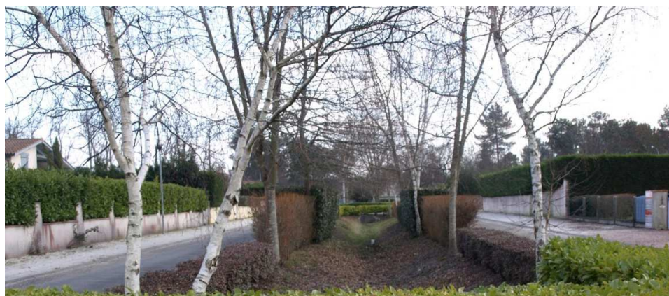
Exemple de noue de récupération des eaux pluviales en terre-plein des voiries d'un lotissement à Génissan
