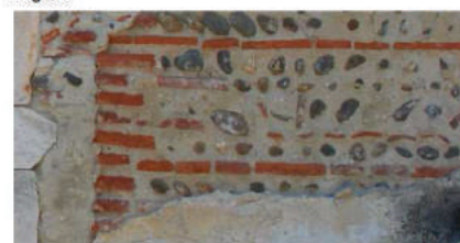
Cauna: la dégradation de l'enduit de ce vieux mur montre les différentes couches d'enduit traditionnel: les galets ne sont pas visibles, à part les plus saillants. Une couche de finition protège le montage à la terre crue et les briquettes fragiles.
