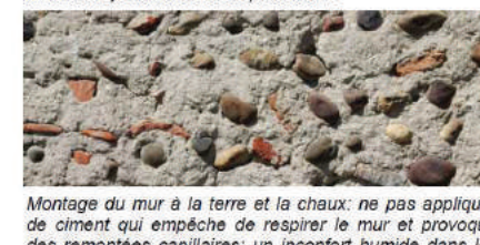
Cauna: restauration d'un mur de galets. Les galets dépassent peu ce qui constitue une entorse moins importante que lorsque les galets sont complètement détournés. En revanche, le sablage des briques les ont entamé la pellicule dure de protection.
